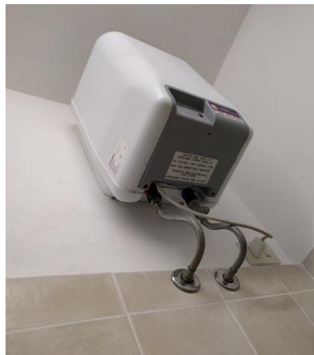
Figura 4.13 - Particolare di un boiler elettrico per la produzione di acqua calda sanitaria
