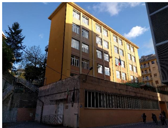
Figura 1.1 - Vista della facciata [esposta a Ovest]
