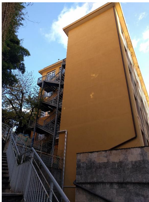
Figura 8.3 – Particolare della facciata esposta a nord da cui si evince la planarità della copertura
